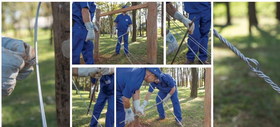
Faça uma trava de segurança, que irá impedir que a torção se desfça quando o canto receber a tração dos fios que serão instalados na cerca.
