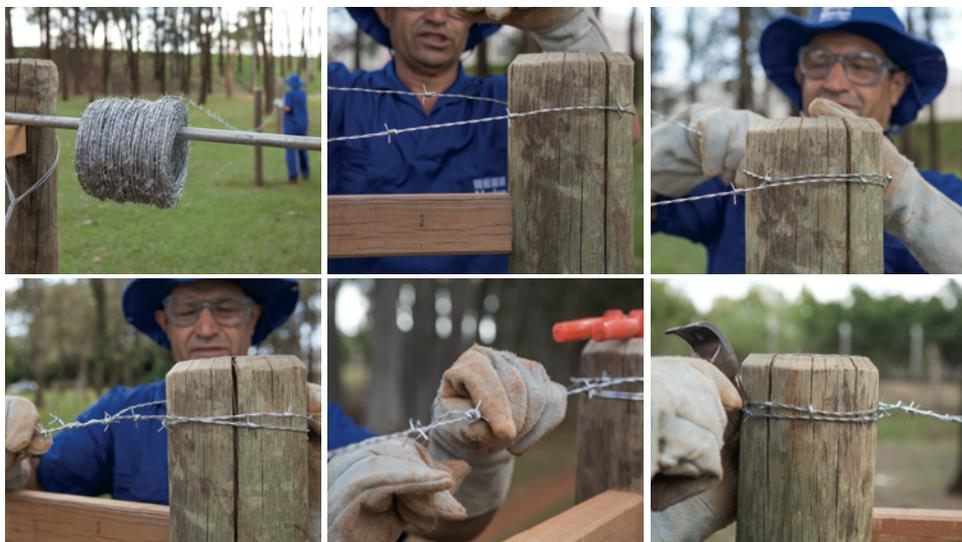
Tracione o arame utilizando um esticador de corrente ou de catraca. Faça a fixação do arame farpado **Nelore Morlan®** nos mourões contramestre e também nos mourões intermediários utilizando grampos para cerca.
