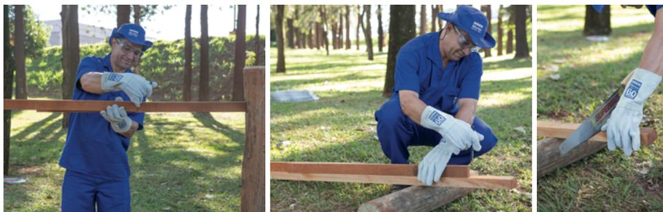
Com o auxílio de um formão, faça a quebra da quina nas 4 faces das pontas da retranca para facilitar o perfeito encaixe no mourão mestre e contramestres e posicione a retranca no encaixe com o auxílio de uma corrente com alavanca.
