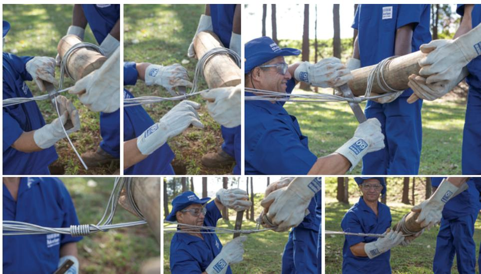
Posicione o morto no buraco, de modo bem encaixado ao barranco e faça a fixação utilizando a terra proveniente das escavações. Dica: faça uma cava na parte inferior da lateral do barranco para aumentar o encaixe do morto.
