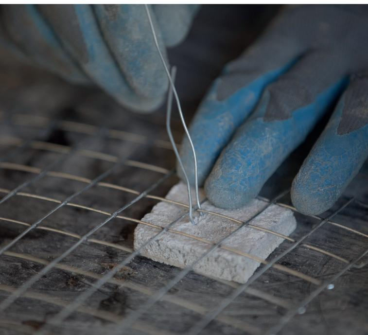
Fig. 15 - Posicionamento do espaçador na tela
