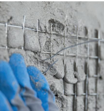
Fig. 30 - Tela penetrando na camada de argamassa
