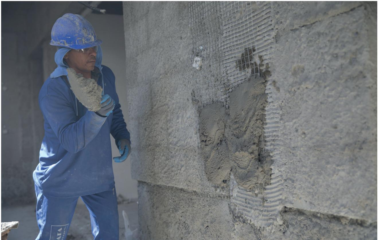
Fig. 24 - Aplicação da argamassa
