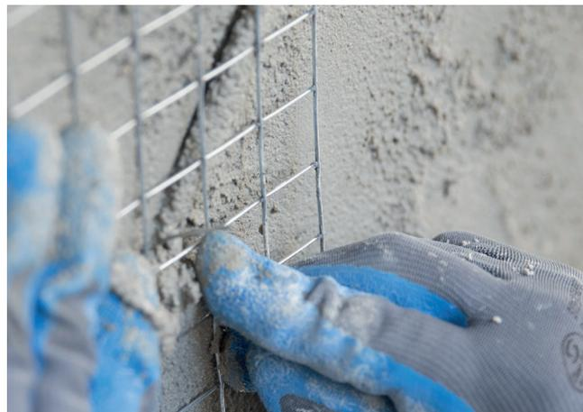
Fig. 31 e 32 - Fixação da tela com os arames
