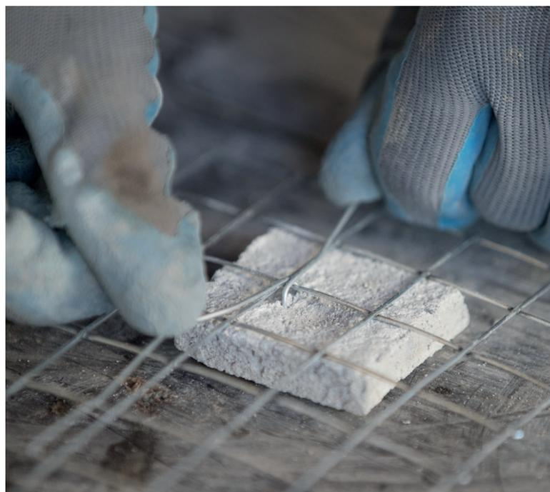
Fig. 16 - Fixação do espaçador na tela
