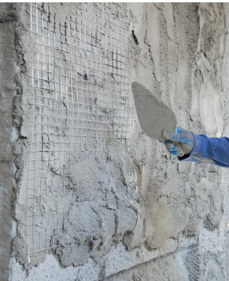
Fig. 33 - Aplicação da última camada de argamassa
