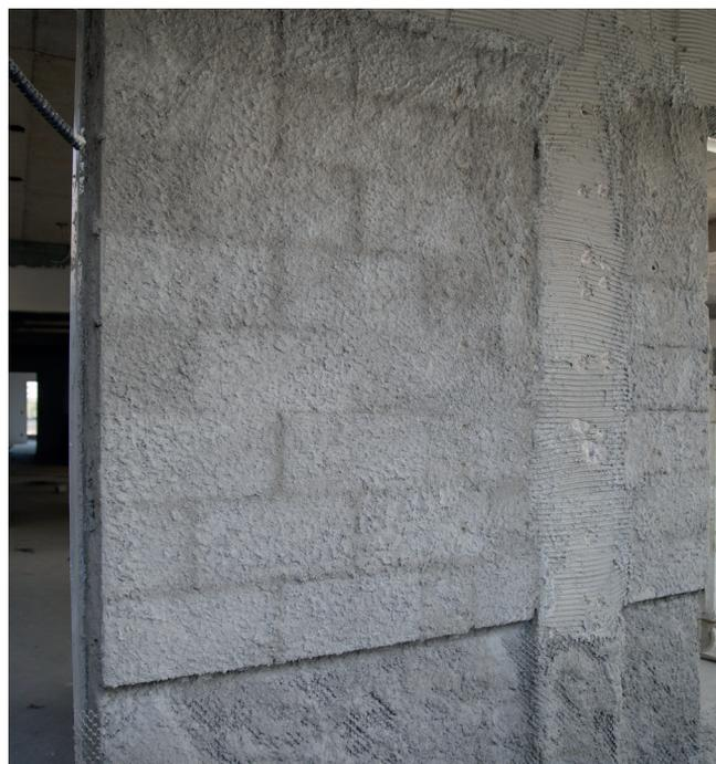
Fig. 18 - Chapisco e alvenaria encunhada
