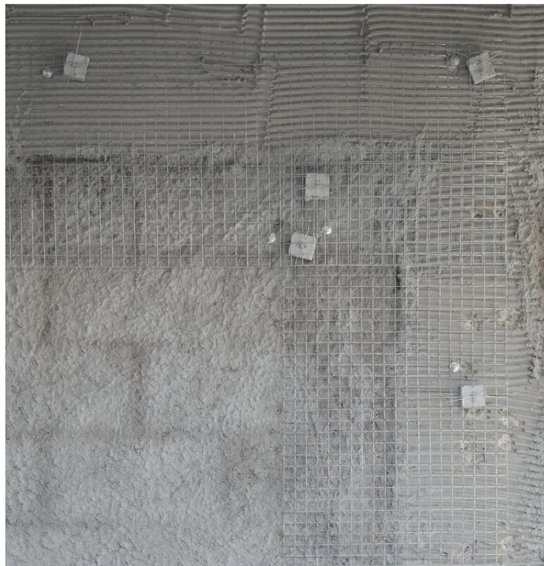
Fig. 21 - Posicionamento da **Fachaforte Morlan**® no encontro entre pilar e alvenaria
