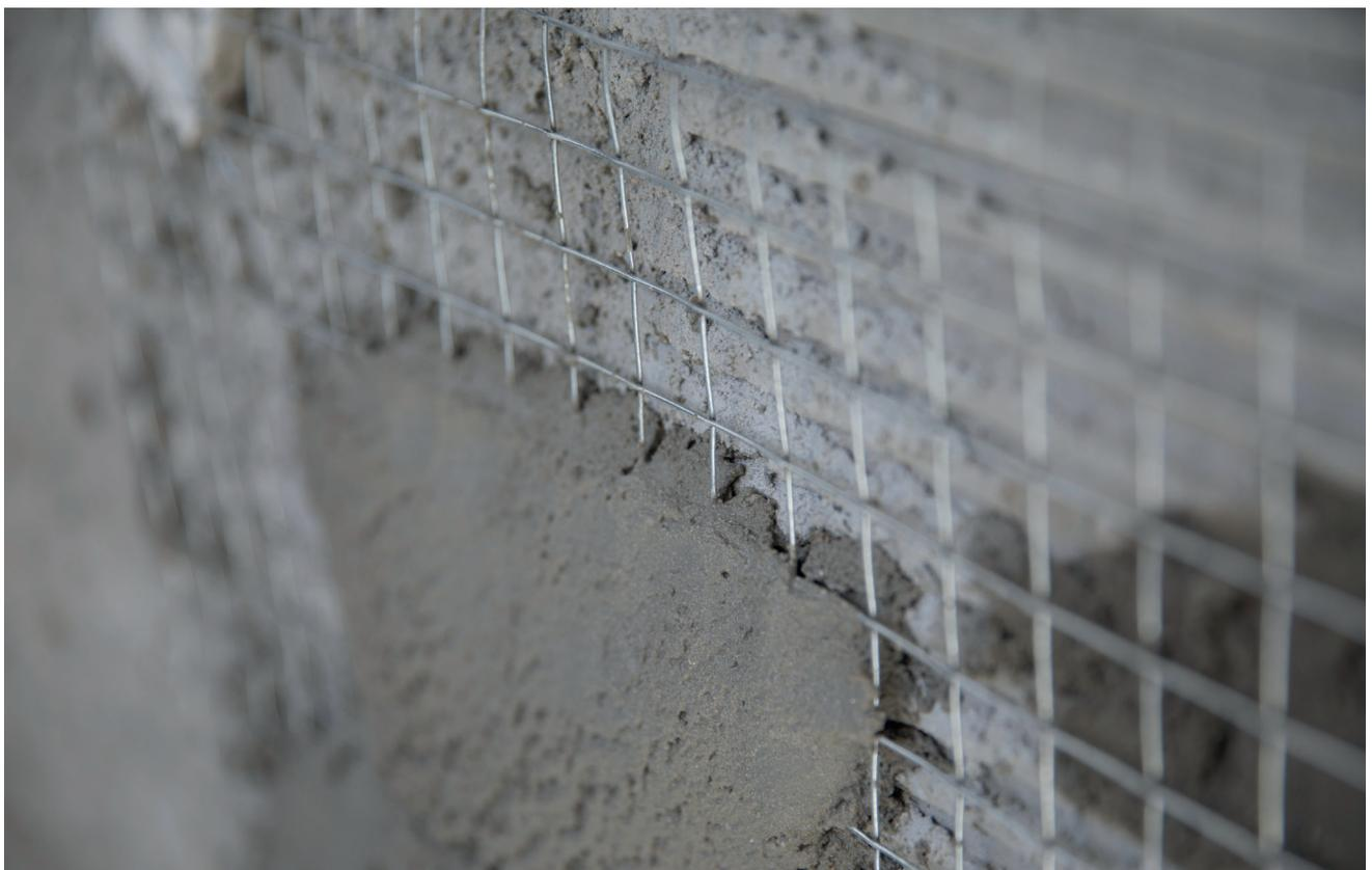
Fig. 25 - Passagem da argamassa através da **Fachaforte Morlan**®
