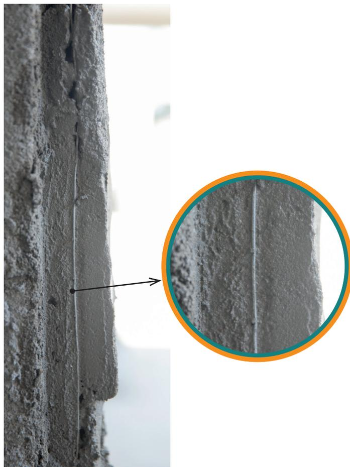
Fig. 34 - Posicionamento da tela no meio da camada de argamassa
