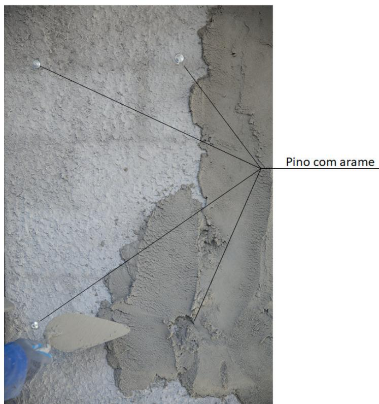
Fig. 27 - Posicionamento dos pinos com arame
