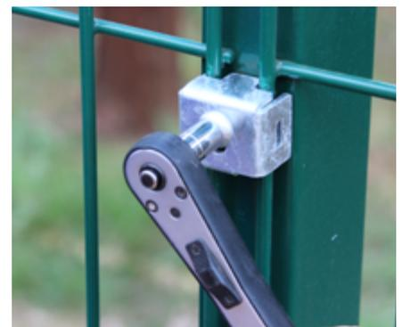
Posicione o parafuso antifurto e aperte até o ponto onde acontecerá a quebra da cabeça do parafuso. Pode ser fixado com: Parafusadeira elétrica ou chave de boca.
