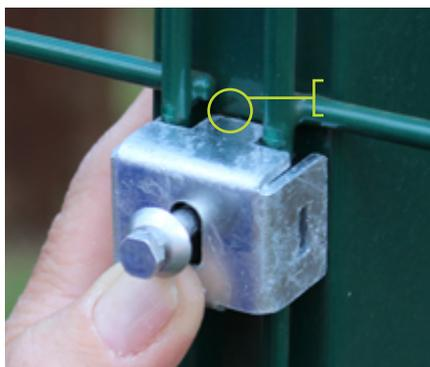
Mantenha um espaço de 4mm entre o fixador e o fio horizontal do **Gradil Morlan®**, para posteriormente encaixar a capa do fixador.
