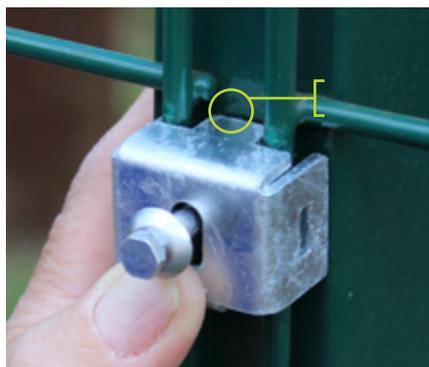
Mantenha um espaço de 4mm entre o fixador e o fio horizontal do **Gradil Morlan®**, para que posteriormente possa encaixar a capa do fixador de segurança.
