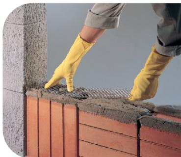
A junta horizontal de argamassa deve ser plenamente preenchida na posição onde as telas serão colocadas. O mesmo cuidado deve ser observado na junta vertical entre parede e pilar.
