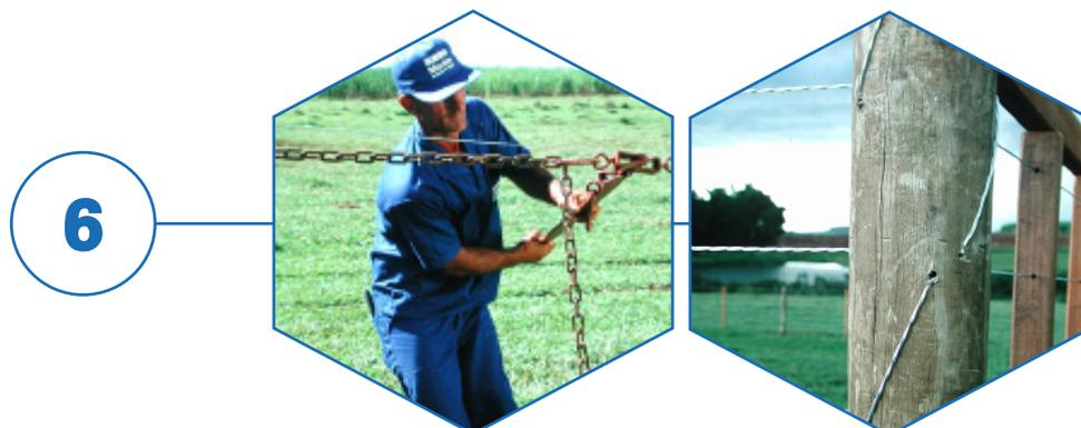
Essa operação deve se repetir em todos os fios da cerca. Ao chegar no último fio, a cordoalha deverá ser fixada com um esticador de parafuso e arrematada da mesma forma que no primeiro.
